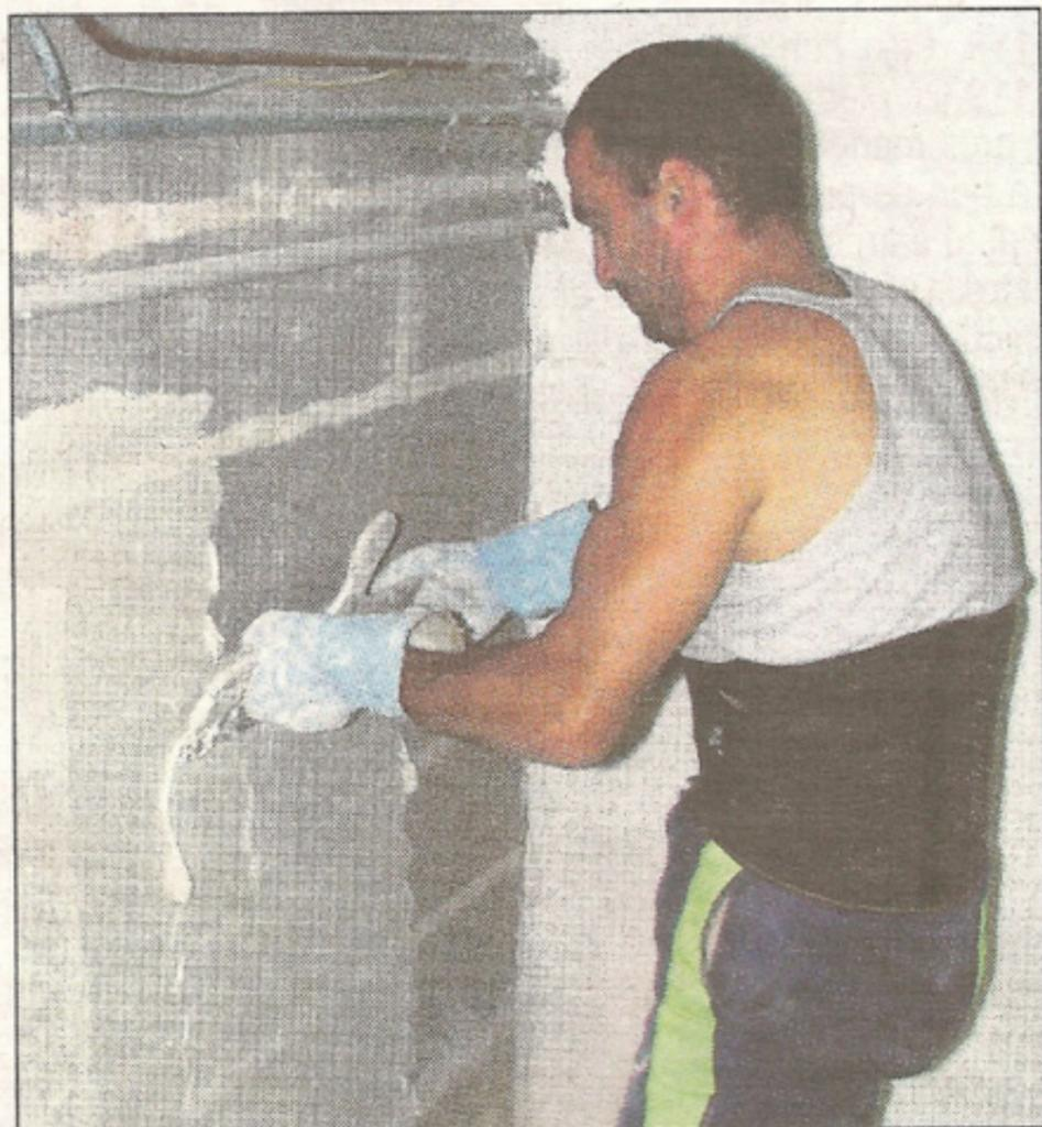
Le cuvelage consiste à imperméabiliser les murs d'une cave grâce à un enduit en trois ou quatre couches.
